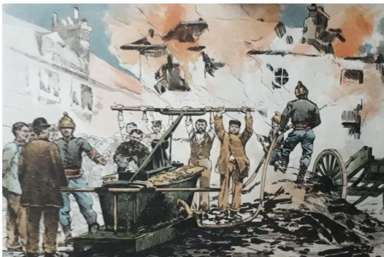
Par un mouvement de balancier, l'eau est expulsée de la pompe vers la lance. Huit hommes à la manœuvre réalisent 92 mouvements.
